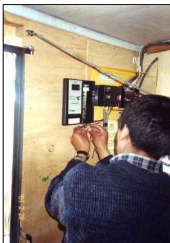
Figura 5.18. Instalação do contador de Ah em uma das instalações fotovoltaicas de Los Uros. [Foto: F. Morante, 28/02/2001]
