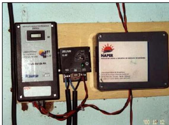
Figura 5.9. Contador e sistema de controle de uma instalação FV de Pedra Branca.
