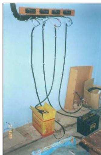
*Figura 3.5. Baterias sendo recarregadas por um gerador fotovoltaico sem controlador. Huancho Lima–Puno–Peru*
